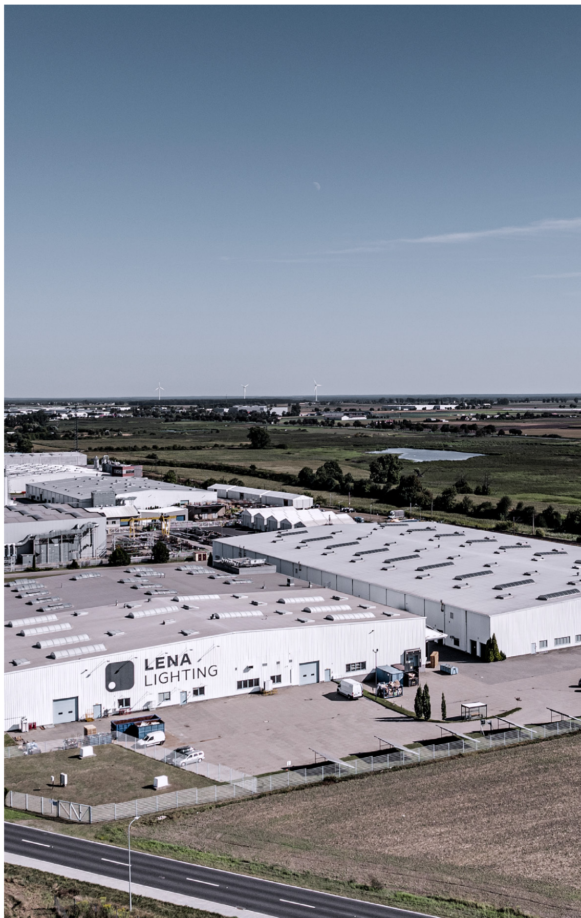
Výrobní haly Lena Lighting ve Środa Wielkopolska
